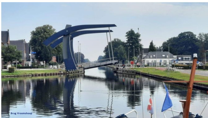
Zuidelijke brug Vroomshoop
