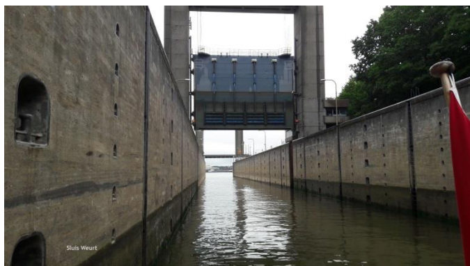
Sluis Weurt met de ontbrekende hefdeur
