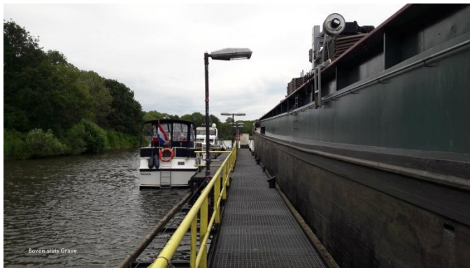
Achter de remmingen sluis Grave
