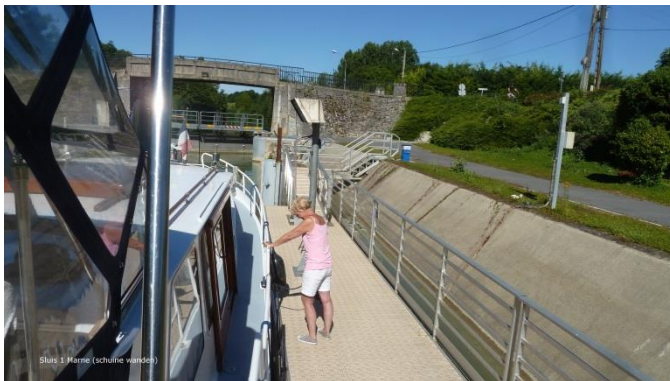
Sluis met schuine wanden met ponton
