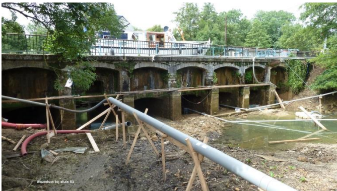
Aqueduct in onderhoud
