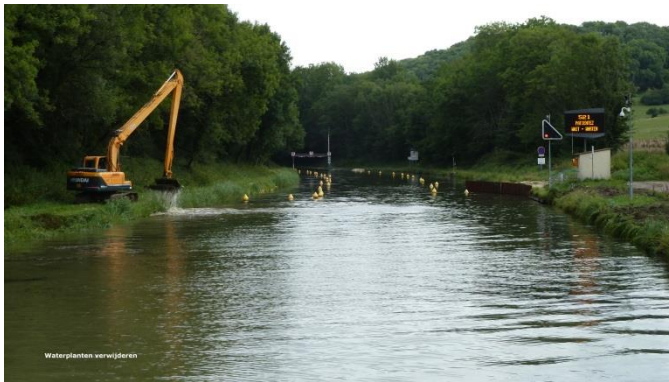
Waterplanten verwijderen voor de tunnel
