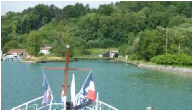
Aanloop tunnel van Foug
