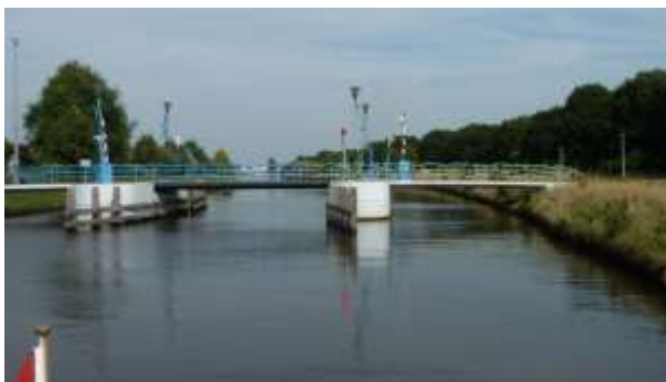
Brug of kunstwerk?
