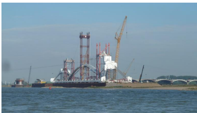
3e Waalbrug in aanbouw
