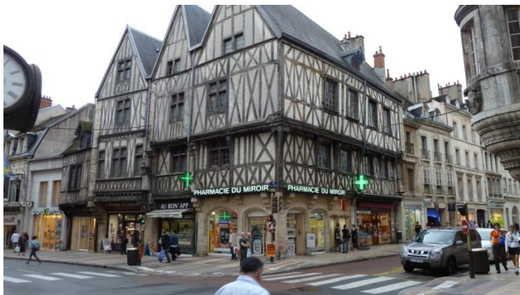
Vakwerk in Dijon
