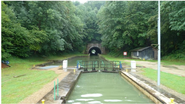
Tunnel van Saint Aignan (200 m)
