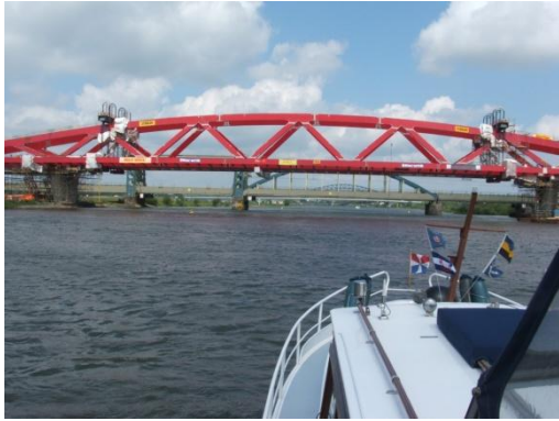
Spoorbrug in aanbouw Zwolle
